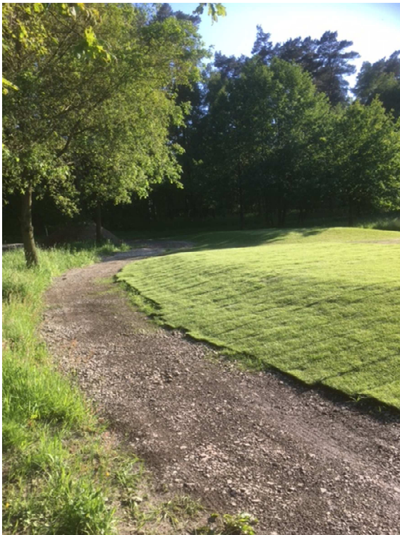
Rasensoden wurden auf dem Abschlag sowie auf dem Approachbereich des neuen Loch 8 ausgelegt.
